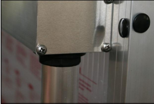
Das Fallrohr wird auf den schon montierten Fallrohrstutzen aufgeschoben.
