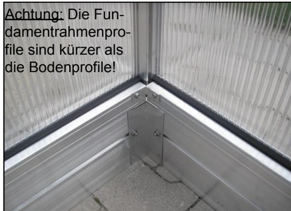
In den Ecken der Fundamentrahmenprofile je eine Schraube M6 x 12 (S12) einziehen, Eckwinkel (V26) aufstecken und mit Mutter M6 (S1) verschrauben.
